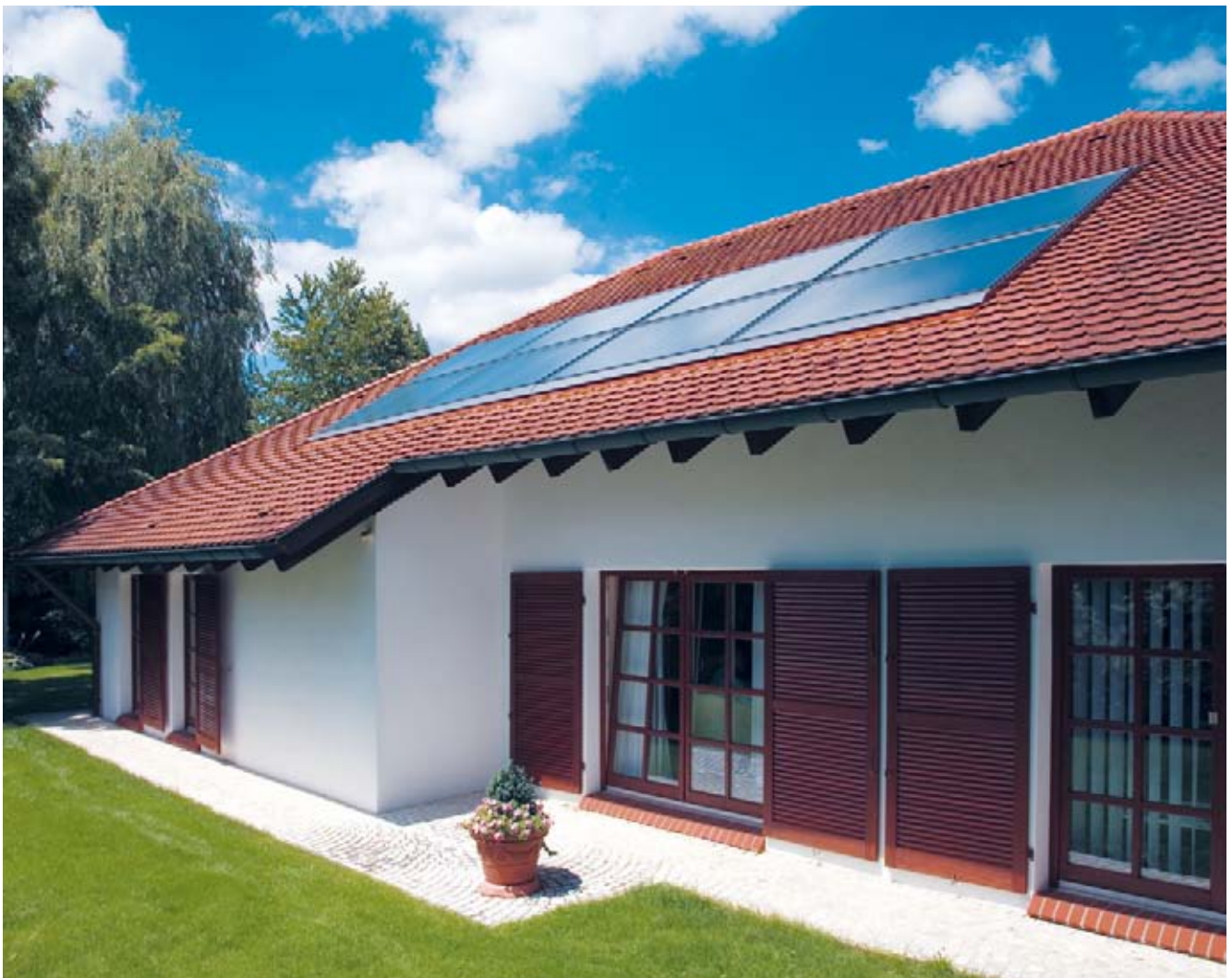
8 collettori orizzontali integrati nel tetto
